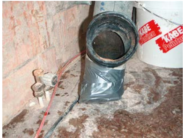
4 Tubo pronto per lo smaltimento, con estremità sigillata con nastro adesivo.
