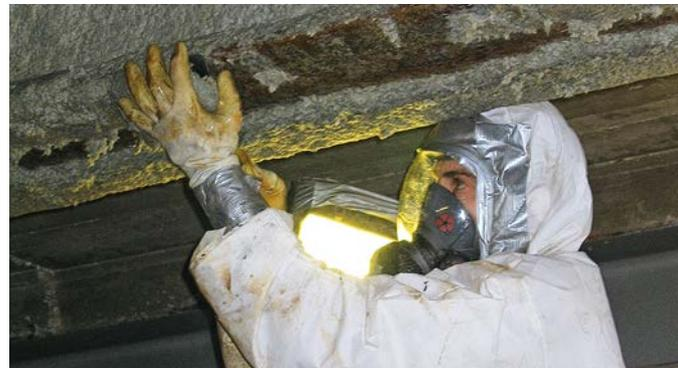
Rimozione solo da parte di ditte specializzate in bonifiche da amianto riconosciute
